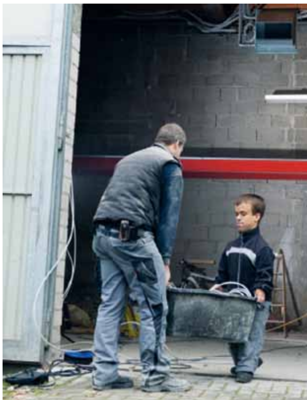
Teamwork. Den Ausbau des neuen Spritzenhauses nehmen die Feuerwehrmänner in ihrer Freizeit selbst in die Hand.
